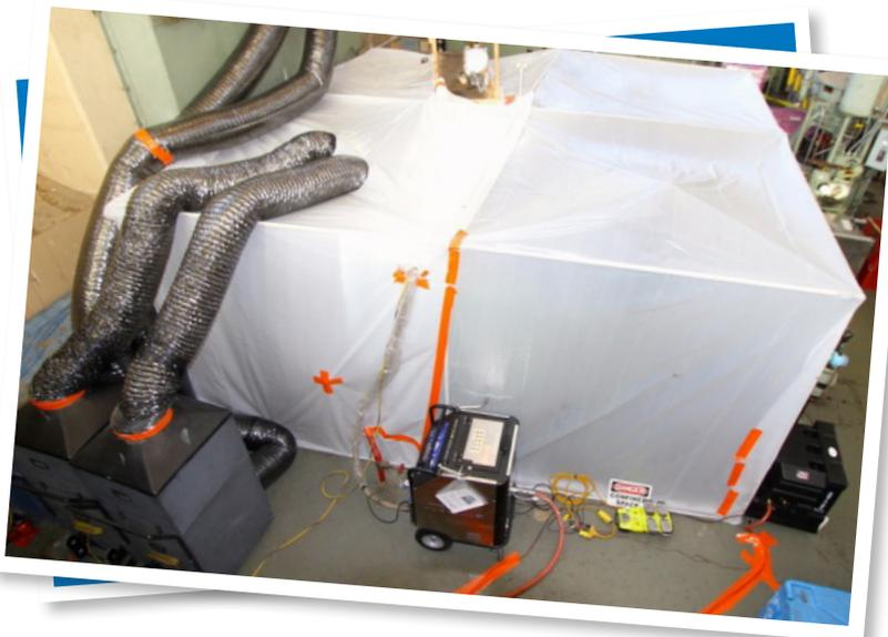
Die SDI Select 60 konnte außerhalb der Sicherheitsumschließung mit einem 12 m Schlauch zu platziert werden. Das vereinfachte und verschnellerte den Prozess.
